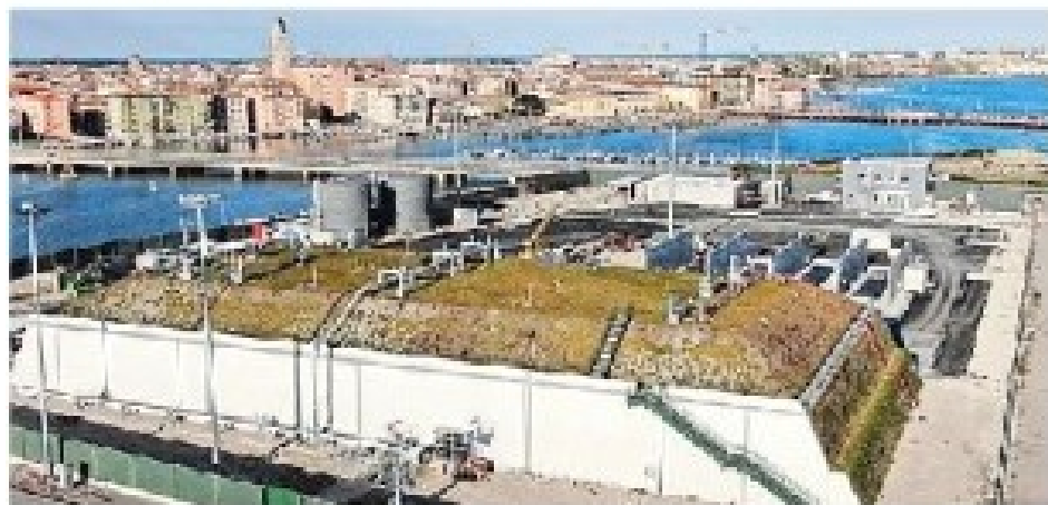
L'area dell'impianto gpl a Val da Rio
