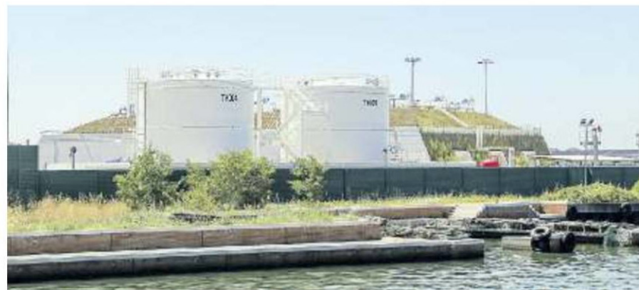
DEPOSITO L'area in cui è stato costruita la struttura che doveva essere gestita da Socogas
