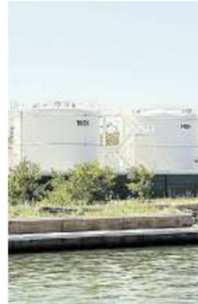
LA “BATTAGLIA” SUL DEPOSITO L'impianto quasi ultimato
