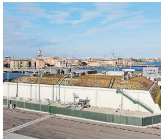
L'impianto Gpl realizzato a Chioggia
